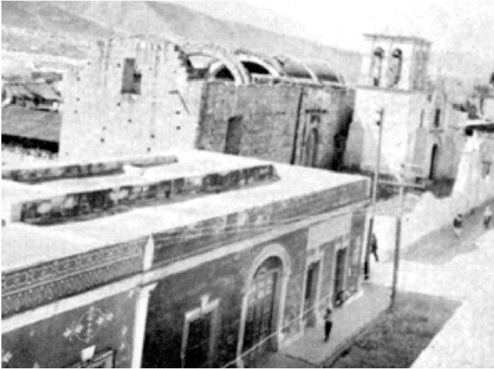
Bóveda del templo y convento de san Andrés, en Monterrey, durante su demolición. Imagen de Internet.
